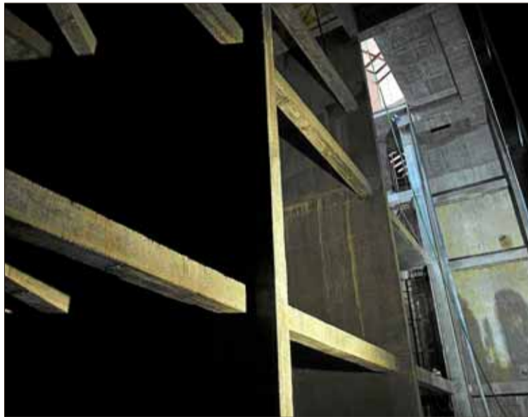
Disposición de los cubículos donde se colocarán los coches, aún sin la robótica.
